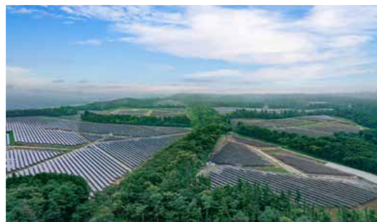
日本福岛西乡村 7.65 万千瓦光伏项目全容量并网
