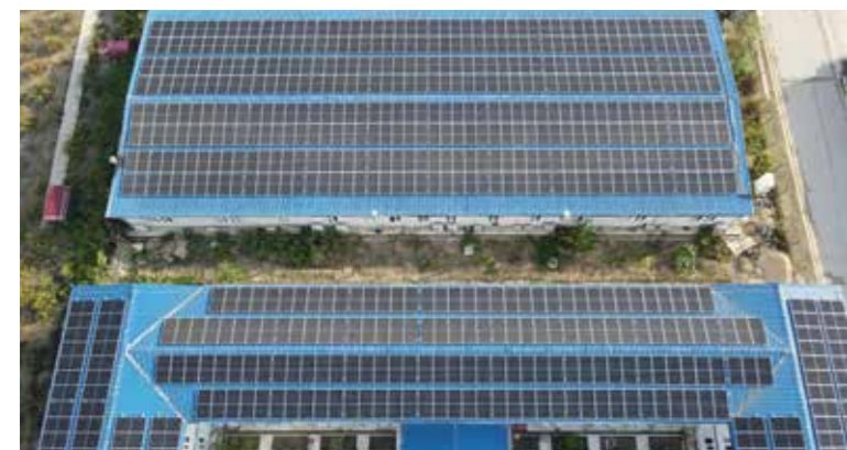
土耳其胡努特鲁风光混合电站项目首批屋顶光伏组件顺利并网，充分利用闲置土地和已构筑屋顶，是土耳其首批批准的煤电 + 新能源“多能源混合型发电站”。
